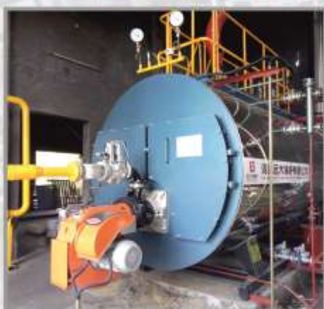
Паровой котел Модель : WNS 2.0-1.0-Y.Q Размер : 8000 x 6000 x 4200 мм Мощность : 6,7 кВт/ч Расход газа : 148 м3/час Производительность : 2 тн/ч пара
