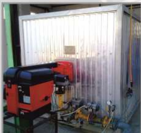
Теплогенератор Модель : HD-400 Размер : 6200 x 2200 x 1800 мм Мощность : 16 кВт/ч Расход газа : 150 м3/час Производительность : 8 500 000 к.кал/ч
